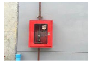
งานระบบท่อดับเพลิงและควบคุม งานระบบดับเพลิงและหัวฉีดโปรยน้ำ งานติดตั้งท่อสูบบระบบดับเพลิง งานติดตั้งตู้ Valve test box
