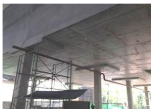
งานระบบท่อดับเพลิงและควบคุม งานระบบดับเพลิงและหัวฉีดโปรยน้ำ งานติดตั้งท่อสูบบระบบดับเพลิง งานติดตั้งตู้ Valve test box
