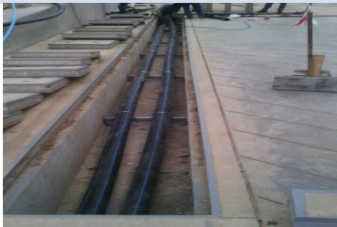
งานติดตั้งท่อสูบน้ำฝน
