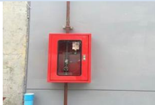
งานติดตั้งตู้ Valve test box
