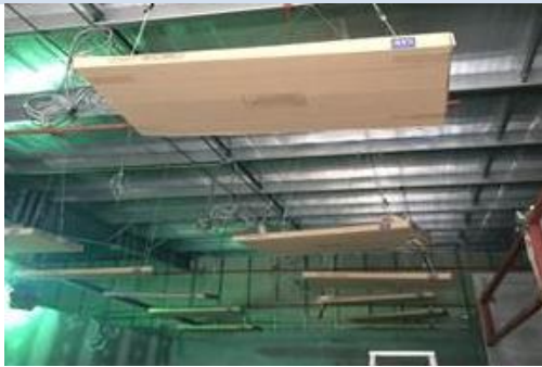
งานติดตั้งดวงโคม
