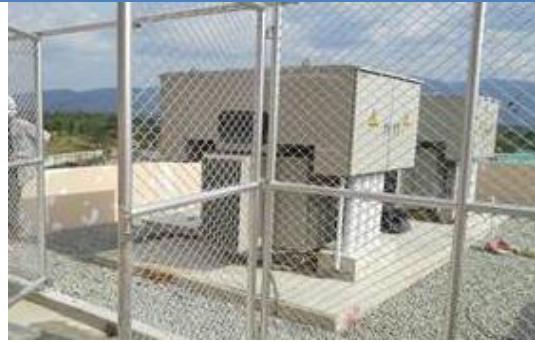
งานติดตั้งหม้อแปลงไฟฟ้า
