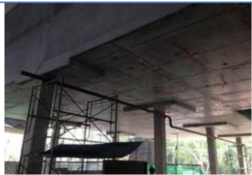
งานระบบดับเพลิงและหัวฉีดโปรยน้ำ
