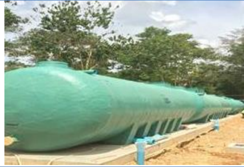
งานระบบระบายน้ำและบำบัดน้ำเสีย
