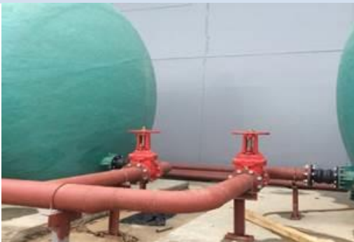
งานติดตั้งท่อสูบบระบบดับเพลิง
