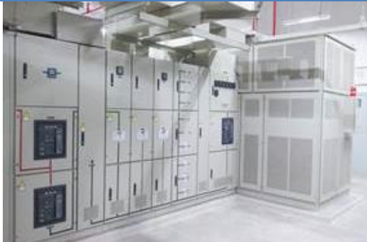
งานห้องควบคุมไฟฟ้า
