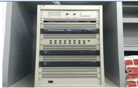
งานระบบเสียงในอาคาร
