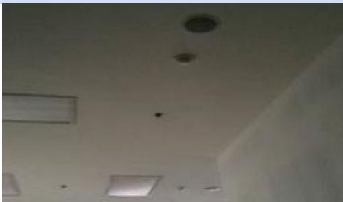
งานติดตั้งลำโพง และ Head detector
