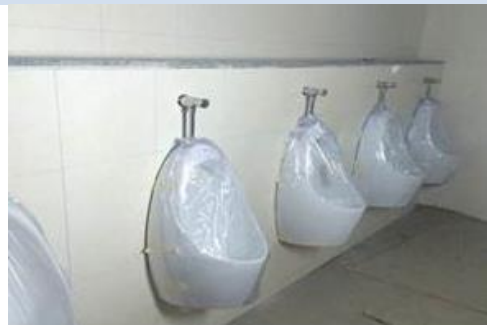
งานติดตั้งระบบสุขภัณฑ์
