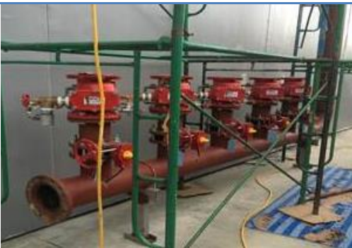
งานระบบท่อดับเพลิงและควบคุม
